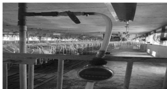
写真3 散水タイマーと壁掛扇風機(豚の後方)
