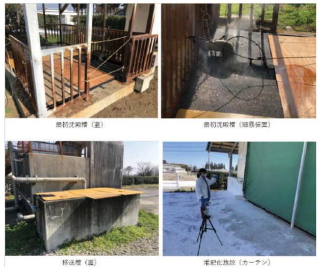
図4 簡易な臭気低減対策（移送槽）
