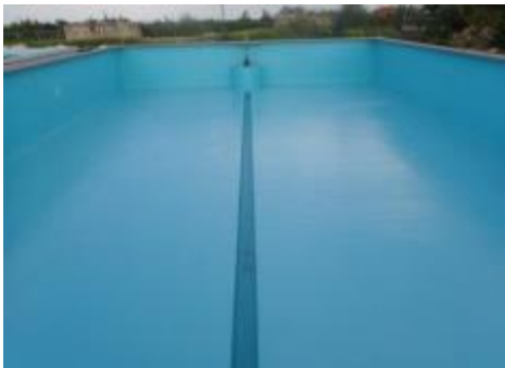
水槽内面FRP防食工事
