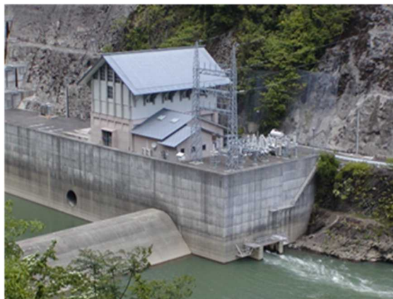
田代八重発電所
