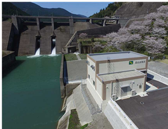
日南ダムと酒谷発電所
