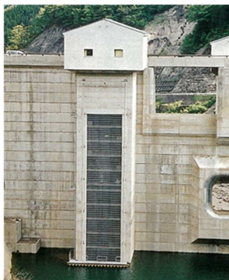
田代八重ダム選択取水設備
