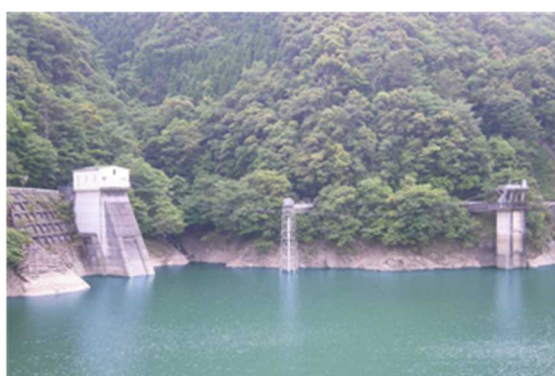
綾北ダム選択取水設備（写真左）
