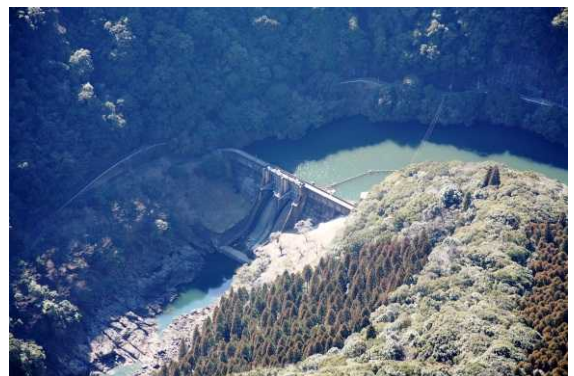
古賀根橋ダム
