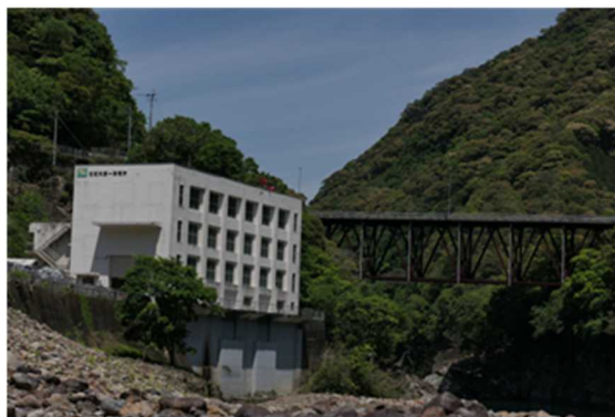
石河内第一発電所
