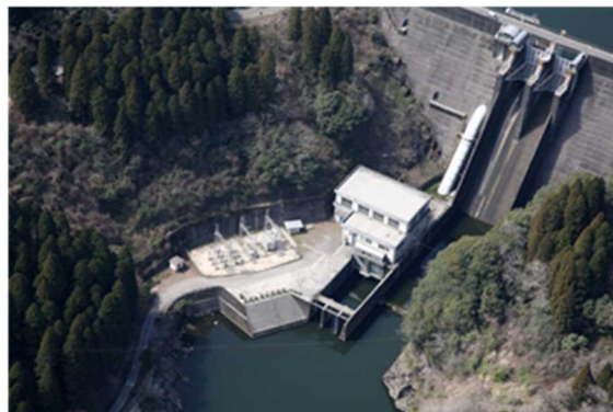
岩瀬川発電所
