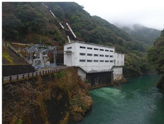
綾第一発電所
