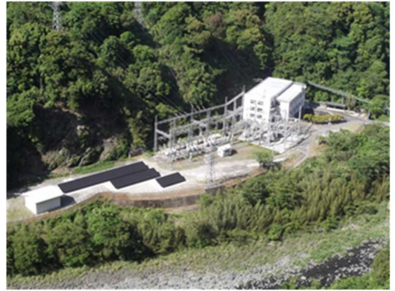
綾第二発電所
