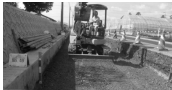
道路の路盤材などに利用
