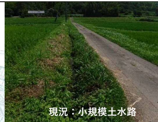
新田西地区 予定箇所
