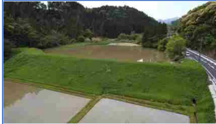
永谷本ため池【実施前】
