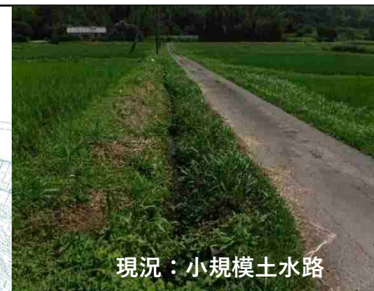
新田西地区 予定箇所
