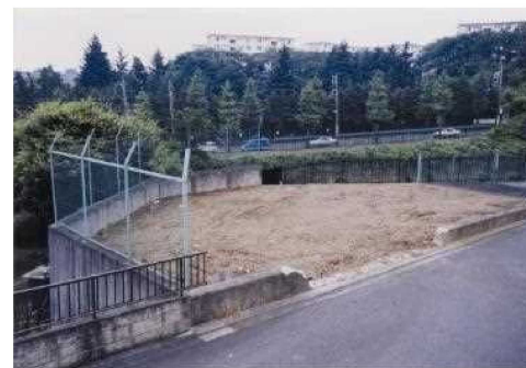
埋め立て後の状況
