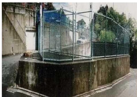
従前の防災調整池
