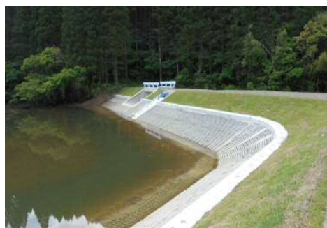
農業用ため池の整備
