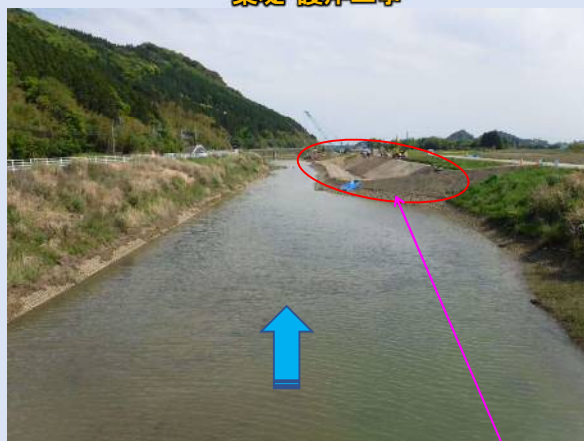
築堤と護岸工事を行い、氾濫を防ぎます
