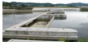
頭首工の改修
