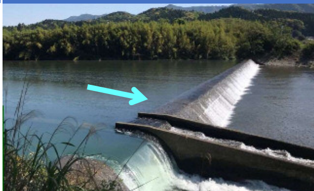
広渡川 内之田井堰
