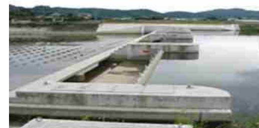
頭首工の改修
