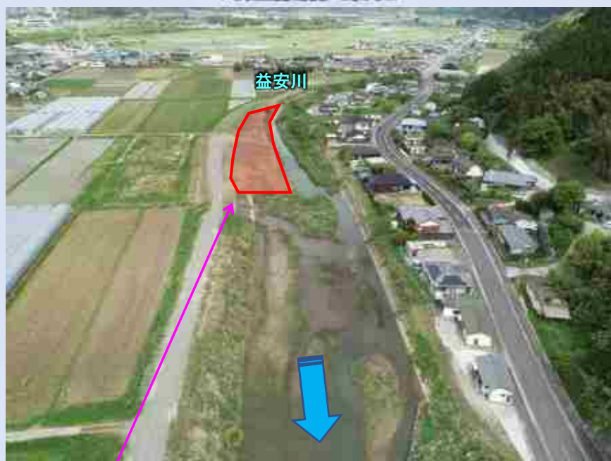
河道掘削・築堤
