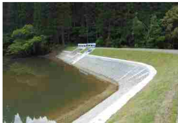
農業用ため池の整備
