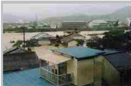
平成9年9月台風19号 (写真:東光寺地区)
