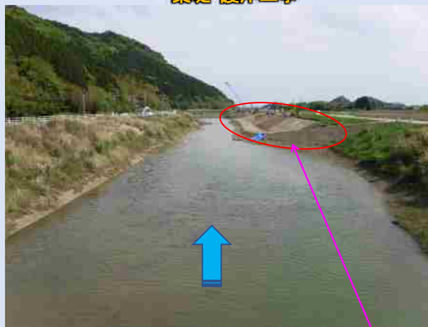
築堤・護岸工事
