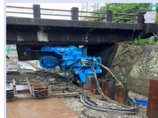
道路橋下の河道拡幅
