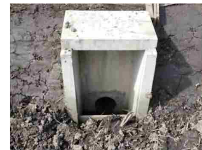
落水口の整備
