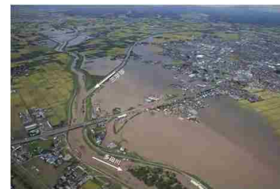
合流部での浸水状況
