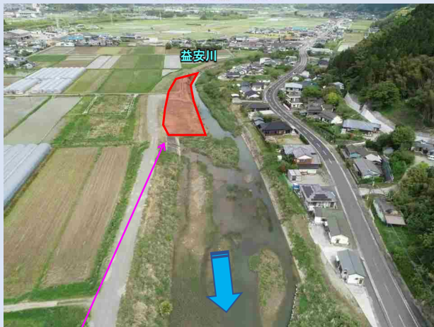
河道を掘削して流下能力を向上させます
