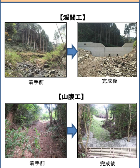
土砂の流出を防止する治山ダムの設置や崩壊地の復旧を実施
