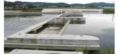
頭首工の改修
