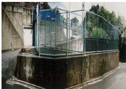
従前の防災調整池
