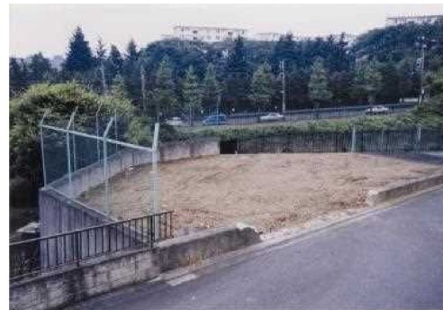
埋め立て後の状況
