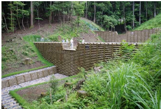
木製谷止工(校倉式)(高原町)
