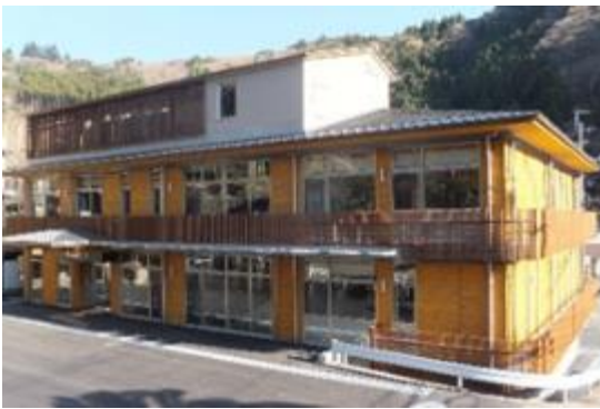
(西米良村新庁舎 全景)
