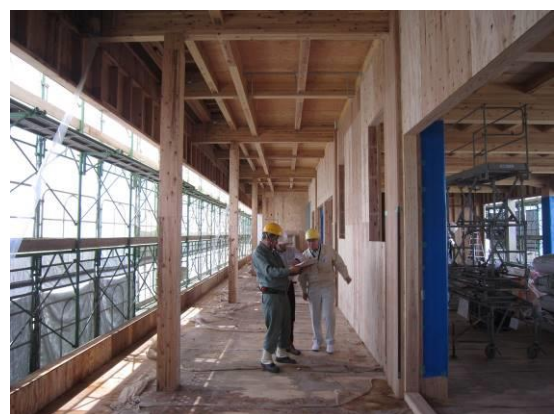
（小林市交流センター建設工事）
