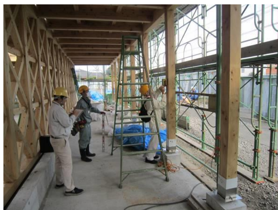
(小林市新庁舎建設工事)
