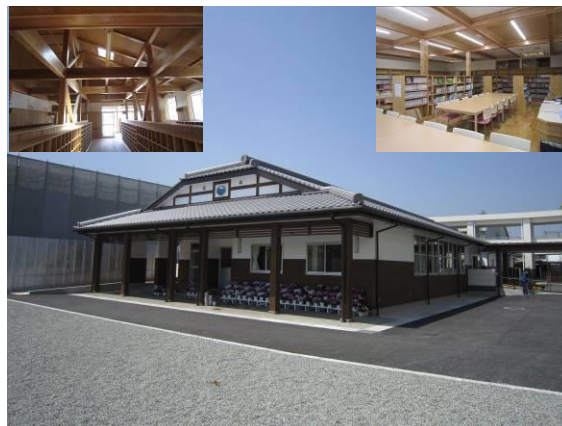
(小林市南小学校木造校舎)
