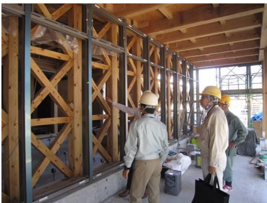
（小林市新庁舎建設工事）
