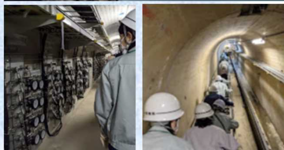
ダム地下の監査廊に並ぶ計器類 300段を超える階段
