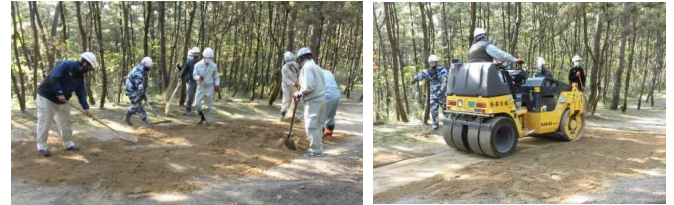
路面補修の様子
