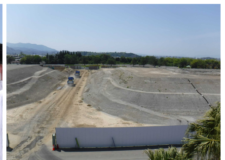
第一陸上競技場南の盛土高台
