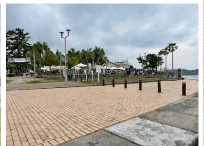
遊歩道 照明施設整備
