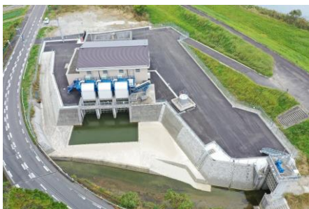
嵐田排水機場 全景
