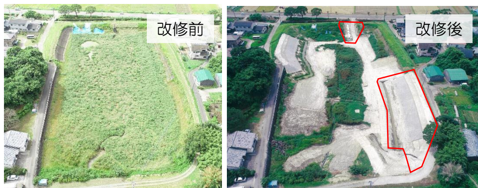
大迫ため池（宮崎市南方）堤体及び底樋改修工事 施工：(株)西條組
