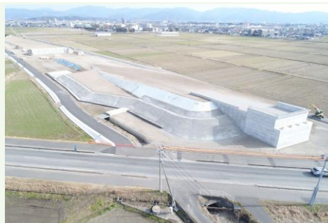
【弊社施工現場】
