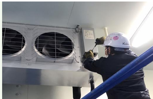
【冷却器設置作業】
