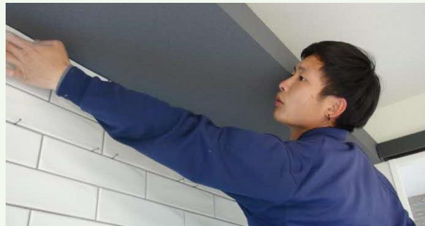
【タイル貼り作業中の阪中君】
