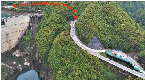
トンネル・橋梁等整備中の 国道219号岩下工区
