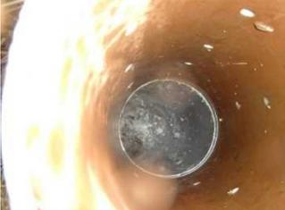
最上流部まで洗管ノズルが到達すると空気孔から水しぶきが発生
