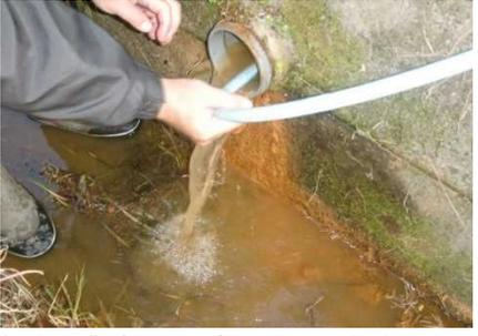
排水作業時間は、押し込み、引き戻しを含め、概ね100m／1時間程度
