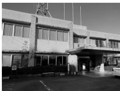
西都総合庁舎(正面)(監査人撮影)
