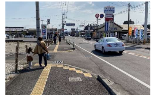
県道高鍋高岡線 歩道整備
