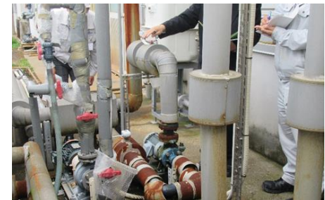
省エネ診断（現場調査）
