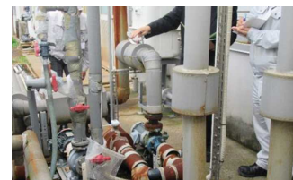
省工之診断（現場調査）
