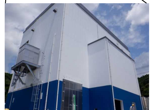
図27 北浦漁港の衛生管理対策(整備中)
