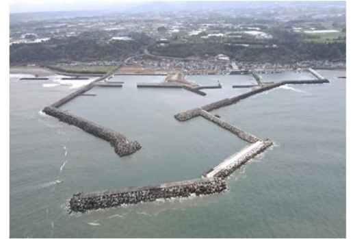
図25 川南漁港の防波堤の整備
