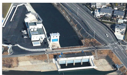
■ 蛇谷排水機場
