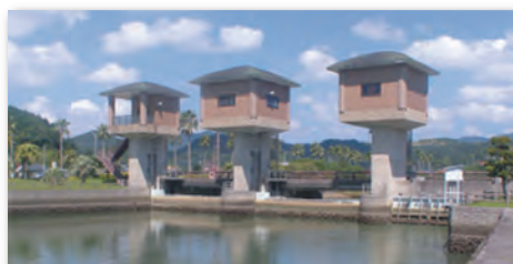
・庄手川防潮堰
