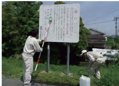
●巡視 (ダム施設)
