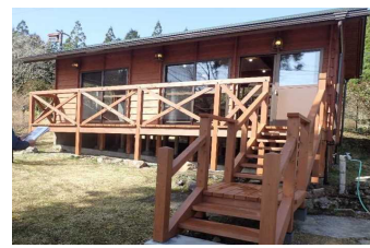
4-1) 九州中央山地国定公園 矢立野営場整備
