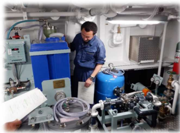
〈写真〉造水機の機関整備
