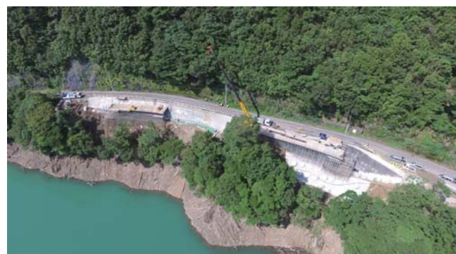
国道219号 越野尾二之渡工区
