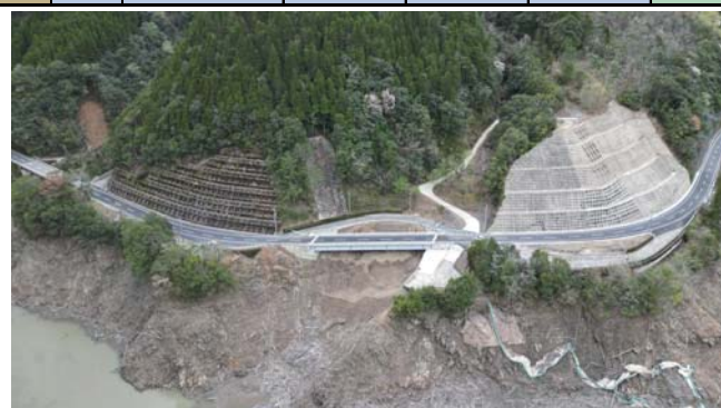
国道219号 越野尾工区
