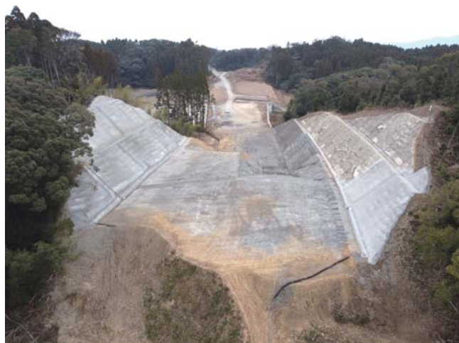
宮崎西環状線 古城工区
