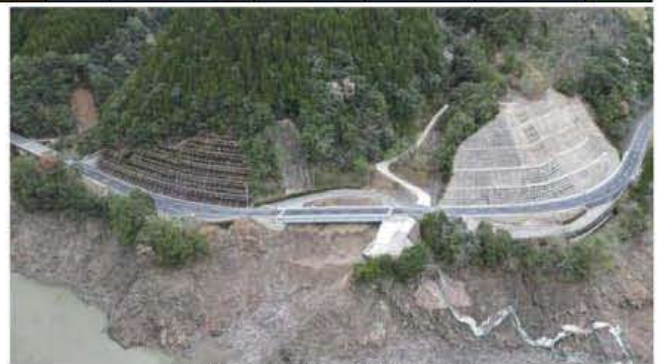
国道219号 越野尾工区
