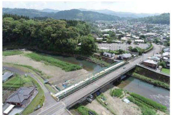
元狩倉日南線 城之下橋側道橋
