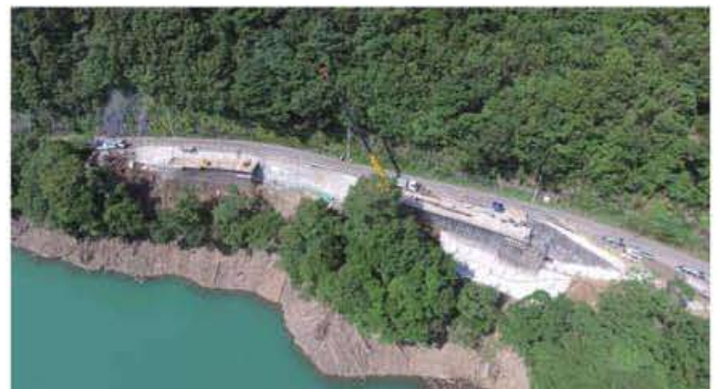
国道219号 越野尾二之渡工区
