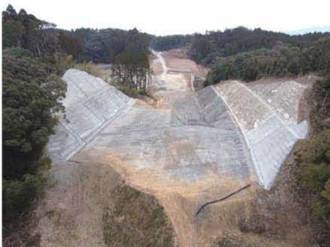
宮崎西環状線 古城工区
