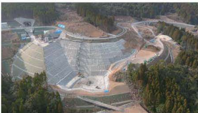
国道447号 真幸工区
