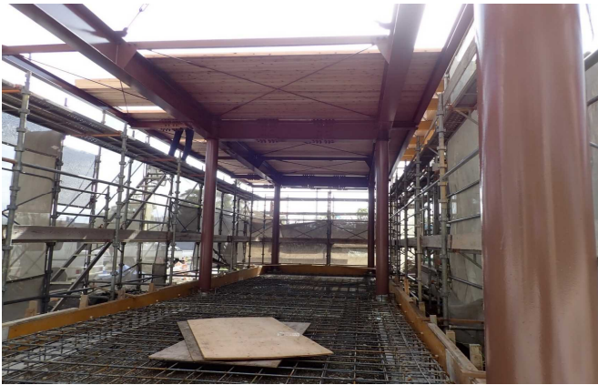
日南市新庁舎(施工中)
