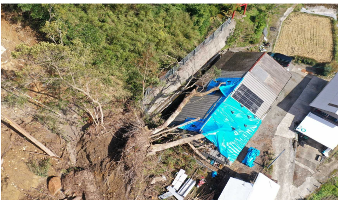
令和4年度荒廃溪流等流木防止対策事業 小原井地区(諸塚村) 着工前
