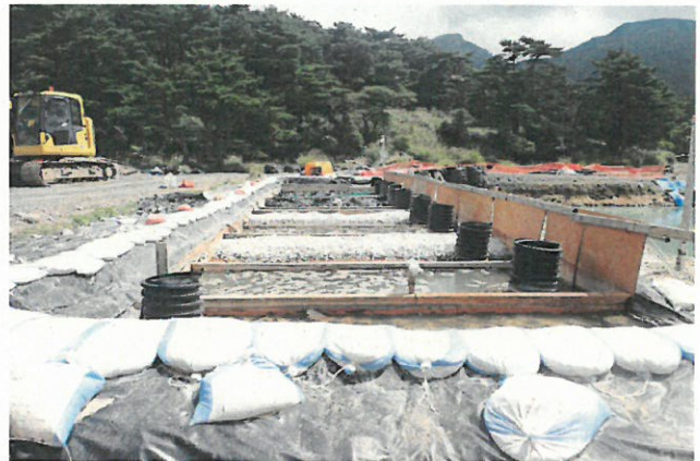
仮設石灰石中和水路
