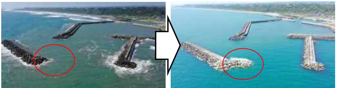
整備を進めている川南漁港の防波堤
