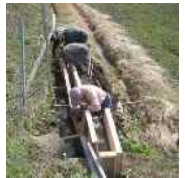
直営施工による水路補修 （日本型直接支払制度）
