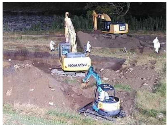
[埋却作業] 県建設業協会派遣
