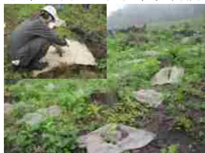
【麻布マット敷設】
