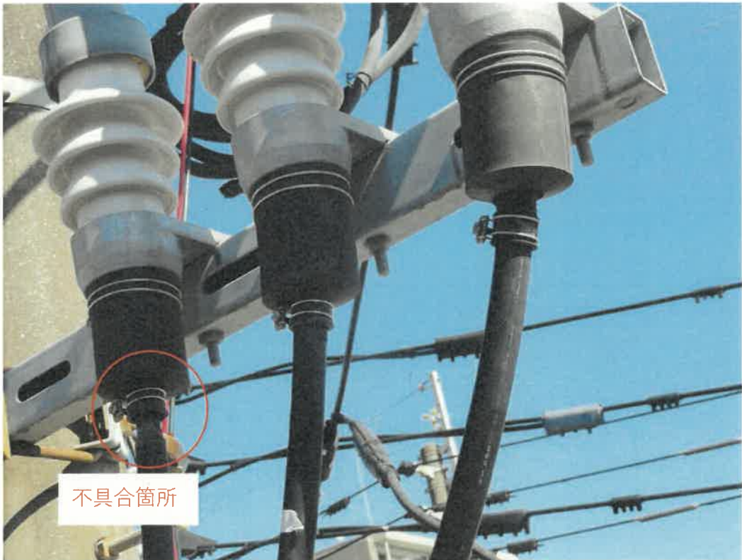
図1 本線用PAS接続箇所
