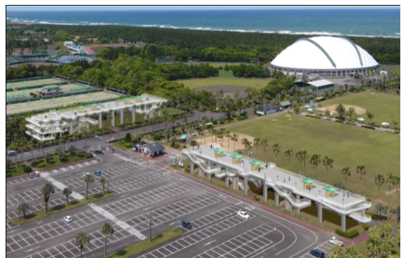
④津波避難デッキ Cエリア
