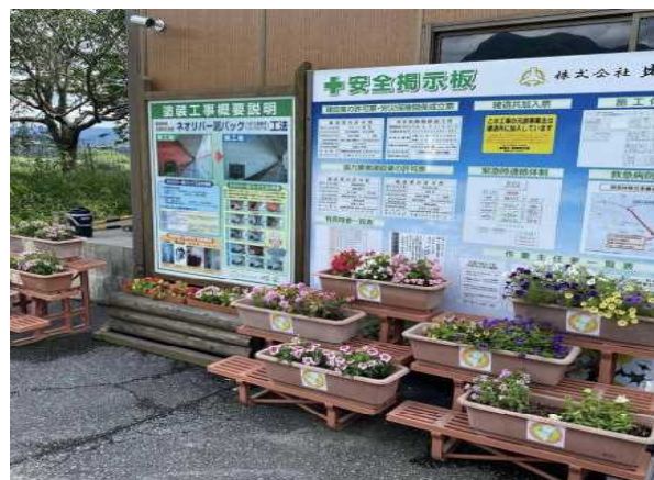
工事現場での取組 (日之影町)
