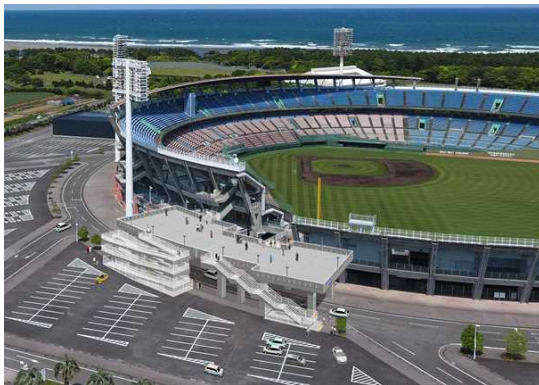
①津波避難デッキ Aエリア
