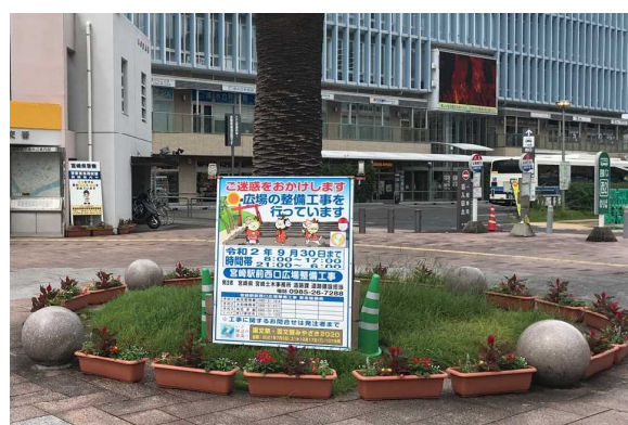
工事現場での取組 (宮崎駅西口駅前広場)
