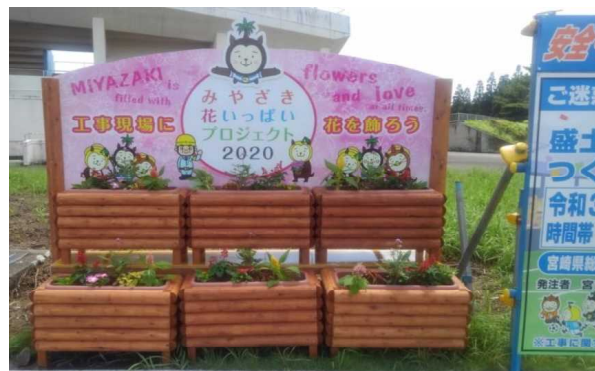
工事現場での取組 (宮崎市)
