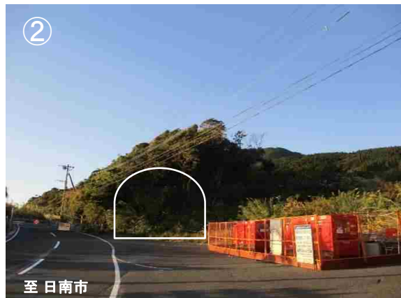
トンネル坑口(近景)
