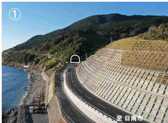
トンネル坑口(遠景)
