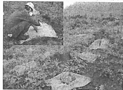
【麻布マット敷設】
