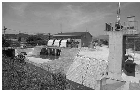
排水機場：河川へポンプで排水
