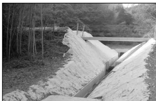
廃止ため池：掘り割った堤体
