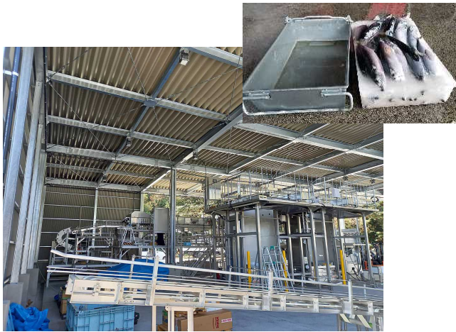
図3 冷凍サバ等のHACCP対応施設整備
