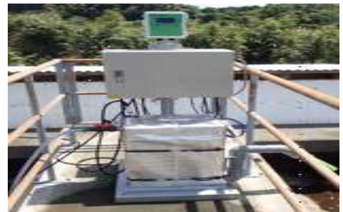
図12 浄化槽BOD監視システム
