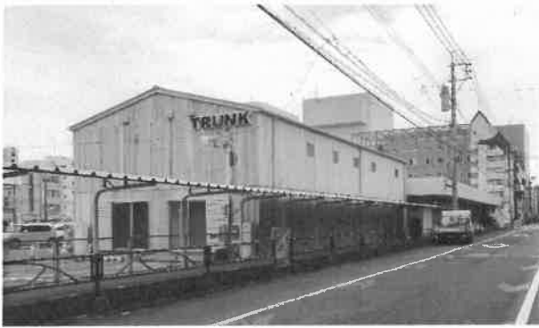
木造施設等の整備（宮崎市）
