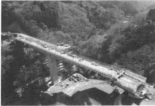
森林基幹道 高千穂・日之影線 乙女大橋架設状況（令和3年3月現在）
